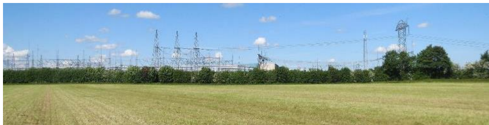
Figur 8.3 Jorddige omkring Højspændingsstation Tjele. Træerne vokser oven på jorddiget.
